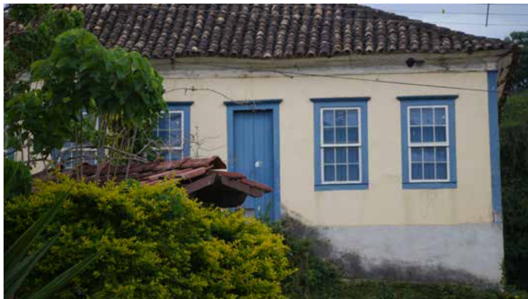
O casarão - patrimônio histórico do distrito. (Foto: Suzana Markus)
